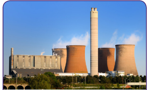
Электростанция мен оның градирнялары
