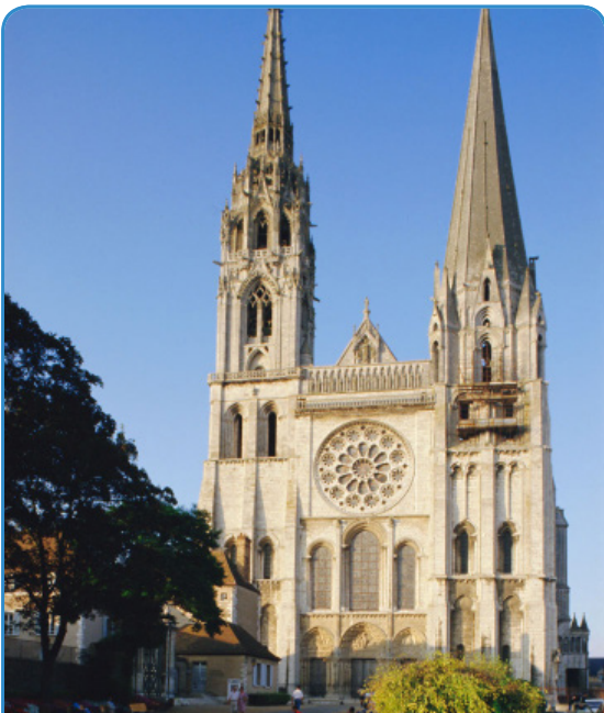
Средневековые архитекторы чертили точные пропорции для своих огромных церквей, используя математику треугольников и квадратов.
